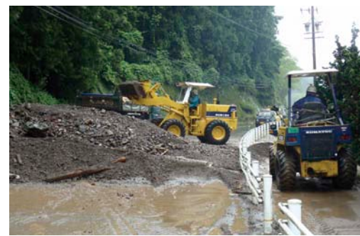
国道152号飯田市南信濃の土砂崩落
