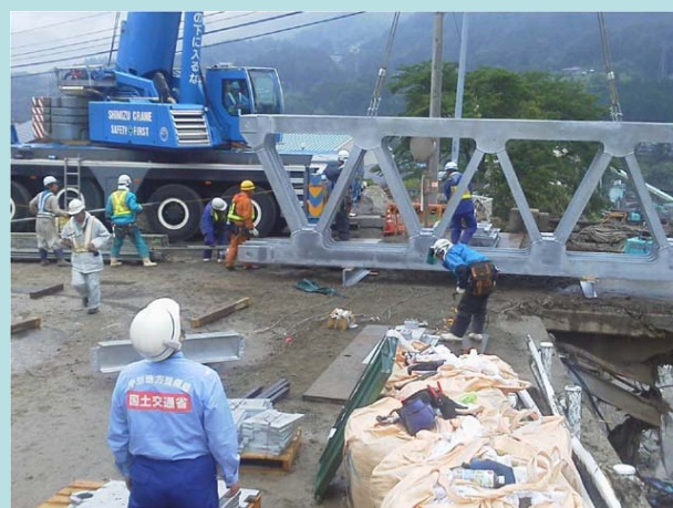
平成26年7月台風8号 県道264号梨子沢橋仮橋架設の技術支援
