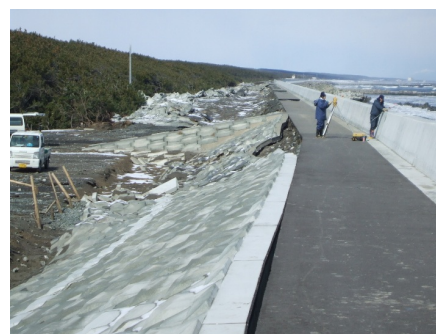
津波の押し波による洗掘に伴う護岸損傷状況
